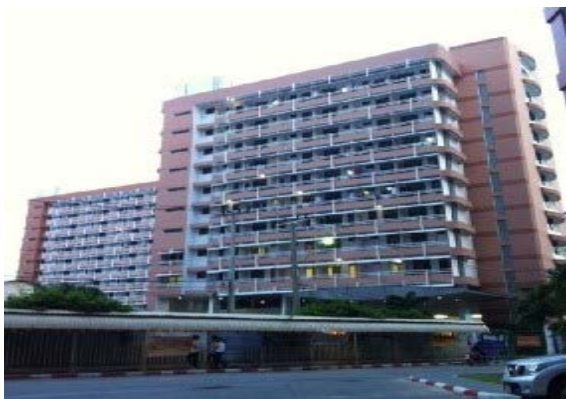
หอพัก มจร.(บางมด)
