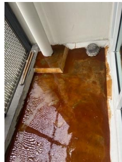
งานซ่อมแซมกันซึมตัวอาคารเคเอกซ์
