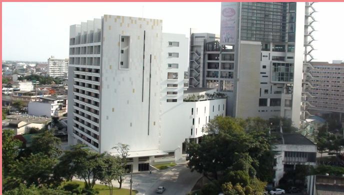
อาคารที่จอดรถ
