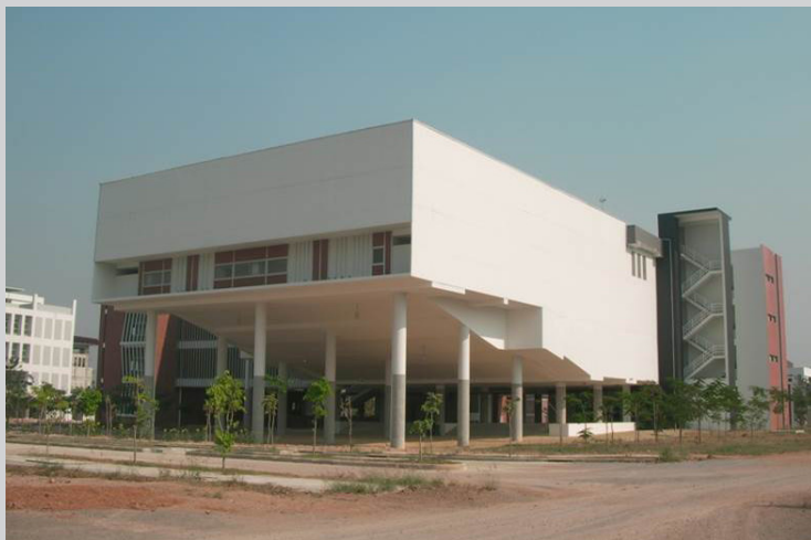
อาคารเรียนรวม
