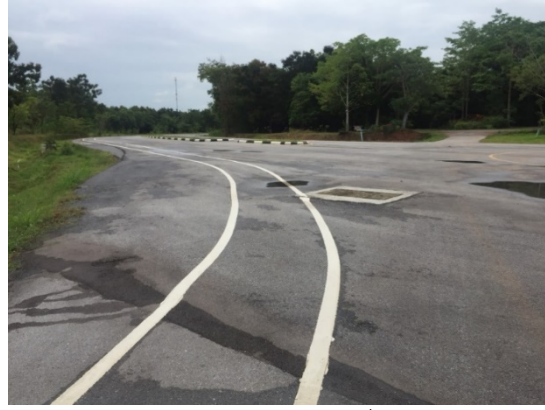
ก่อสร้างถนนระยะที่ 3
