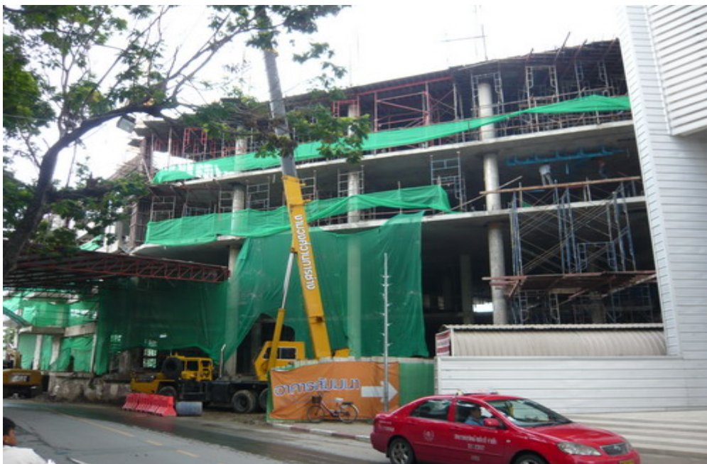
อาคารที่จอดรถสูง 14 ชั้น
